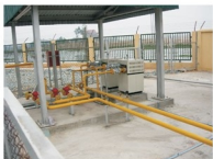
CÔNG TY XÂY LẬP ĐIỆN
