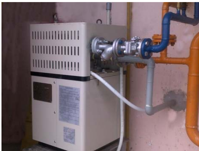
3. Hệ thống máy hóa hơi 100Kg/h
