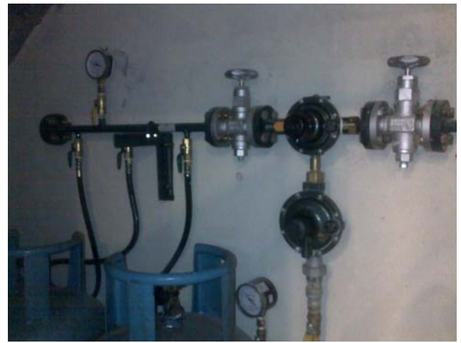
2. Hệ thống van đảo chiều gas hơi
